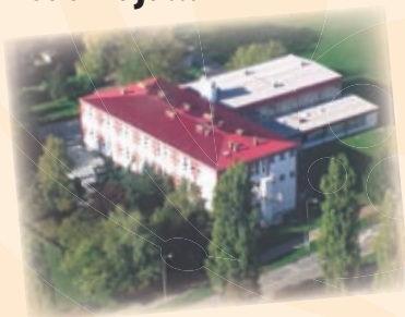
Otvorenje Osnovne škole Siniše Glavaševića str. 4-6
